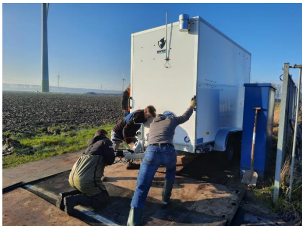
Plaatsing van een meettrailer waarmee we de waterkwaliteit meten
