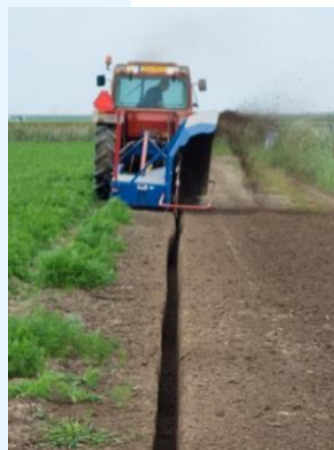
Figuur 2. De infiltratiegreppel wordt aangelegd met een sleuvenfrees.
