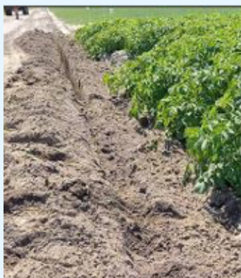
Figuur 5. Een met bomenzand gevulde infiltratiegreppel.
