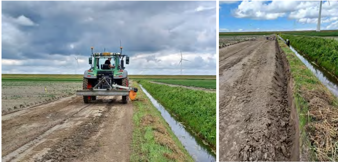
Figuur 2.5 Aanleg van de tweede greppel van de cascadegreppel met een greppelfrees, parallel aan de sloot.
