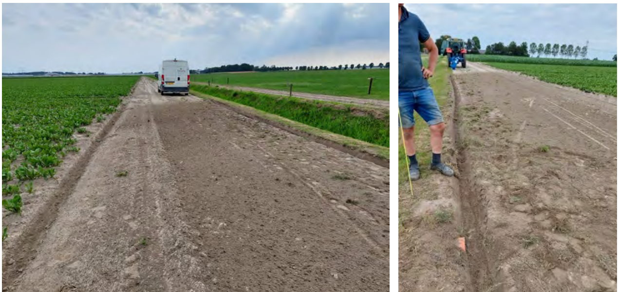
Figuur 2.6 De dubbele greppel in het onderzoek bestaat uit een afvoergreppel voor het gewas langs. Als deze vol is stroomt het water over het kavelpad naar de tweede greppel voor de sloot langs (foto links). In de tweede greppel is de afvoer gemeten (foto rechts).
