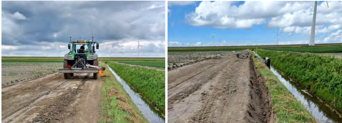
Figuur 4.7 De greppels zijn aangelegd met een schuif die is uitgerust met een schijf (links). De schijf werkt de grond omhoog, die vervolgens door de schuif over het pad wordt verdeeld. Links van het pad ligt al een greppel. De tweede greppel is aangelegd langs de sloot (rechts).
