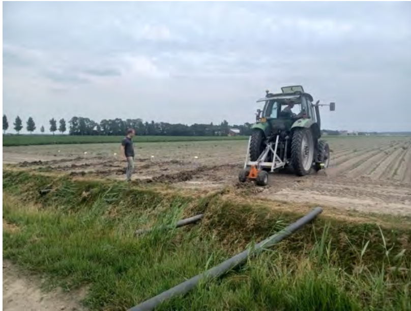
Figuur 3.4 Het aanleggen van de afvoerbuizen onder de kopakker door (links).
