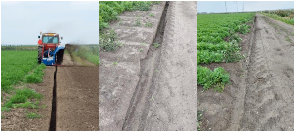
Foto 6.1: Aanleg van de infiltratiesleuf in Swifterbant. Op de helft van het perceel is de infiltratiegreppel leeg gebleven, op de andere helft van het perceel is de infiltratiegreppel gevuld met bomenzand.
