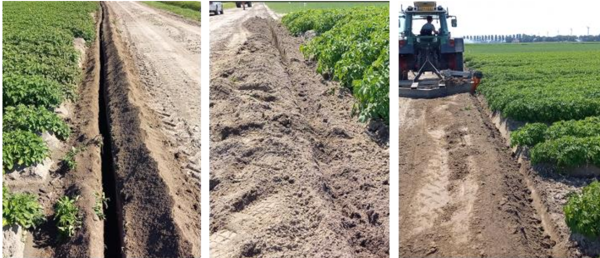
Foto 6.2: Aanleg van de infiltratiegreppel in Espel. Eerst werd de aanwezig afvoergreppel verdiept m.b.v. een sleuvenfrees (links), de sleuf werd gevuld met bomenzand (midden) en werd vervolgens weer in V-vorm afgewerkt (rechts).
